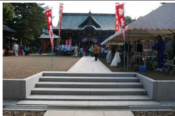
完成した御影石の石段石畳
